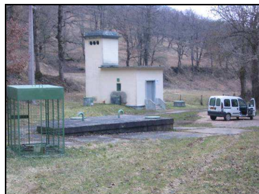
Photo 1 : Captage de la Doux
